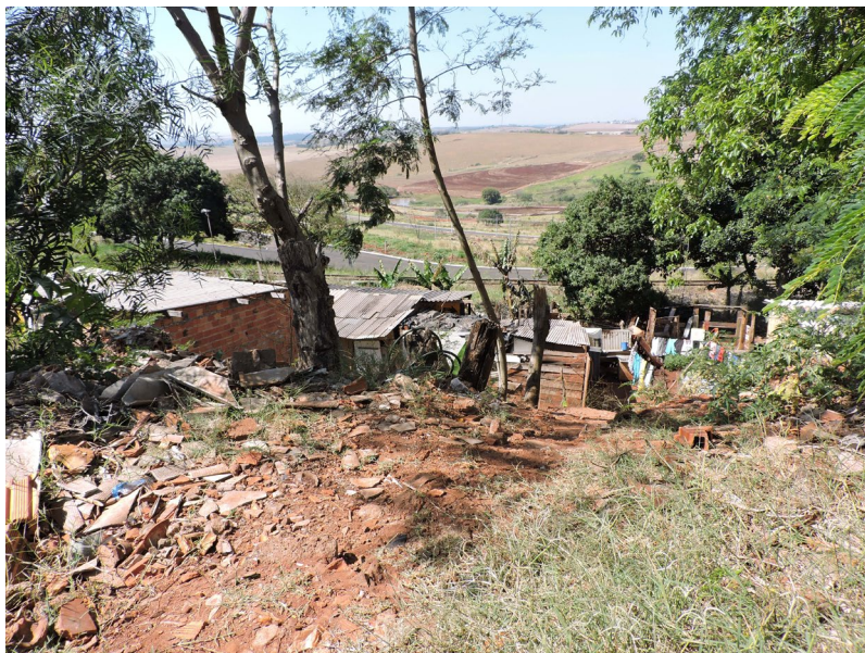
Figura 8 – Ocupação irregular próxima à ferrovia São Paulo-Paraná nas adjacências do Residencial Ivany Paiva Gatti
