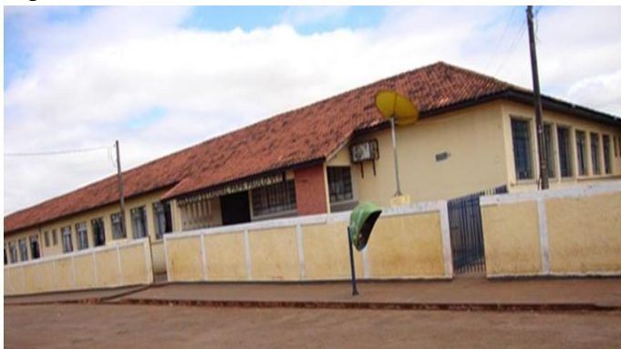
Figura 2 - Fachada do CEPPVI
