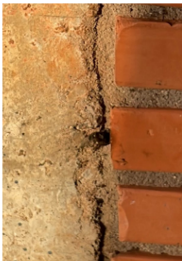
Figura 24: Jataí na parede
