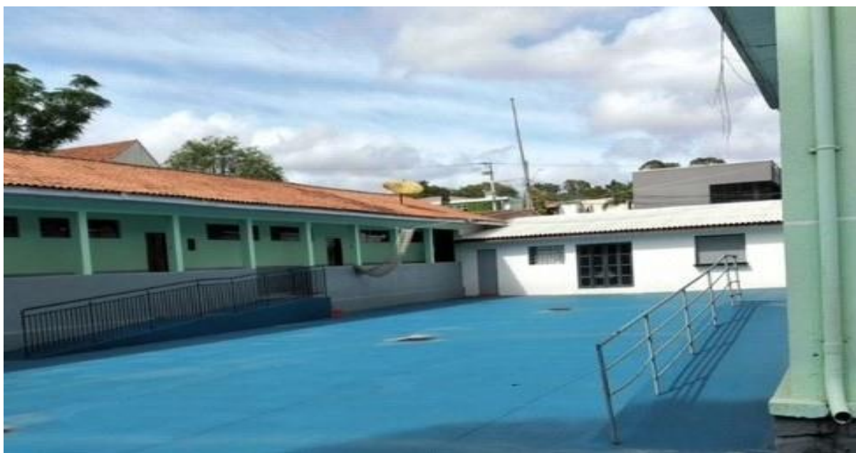
Figura 5- Pintura do espaço da quadra.
