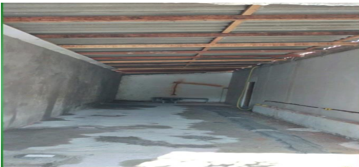
Figura 8- Reestruturação do antigo depósito para a construção da sala de jogos.
