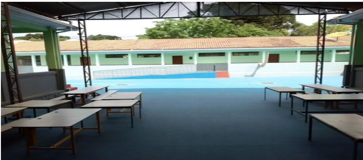
Figura 7- Vista do pátio coberto e das salas dos fundos da escola.
