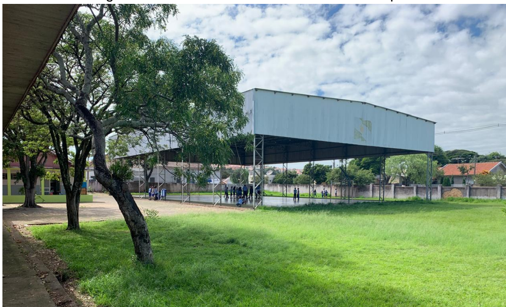
Fotografia 8 – Gramado e Quadra Coberta Poliesportiva.
