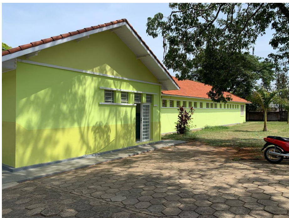
Fotografia 2 – Fachada da parte interna do CEEBJA.
