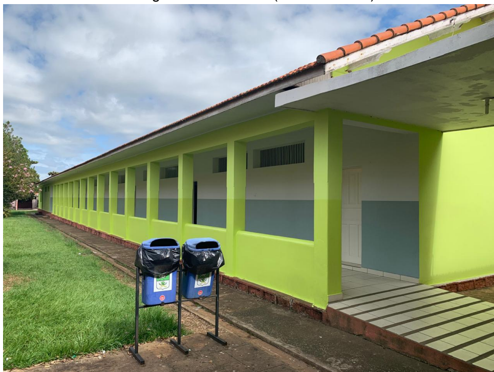
Fotografia 6 – Bloco 2 (Salas de Aula).
