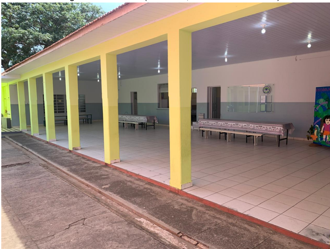
Fotografia 4 – Bloco 3 (Refeitório, Banheiros e Cozinha).
