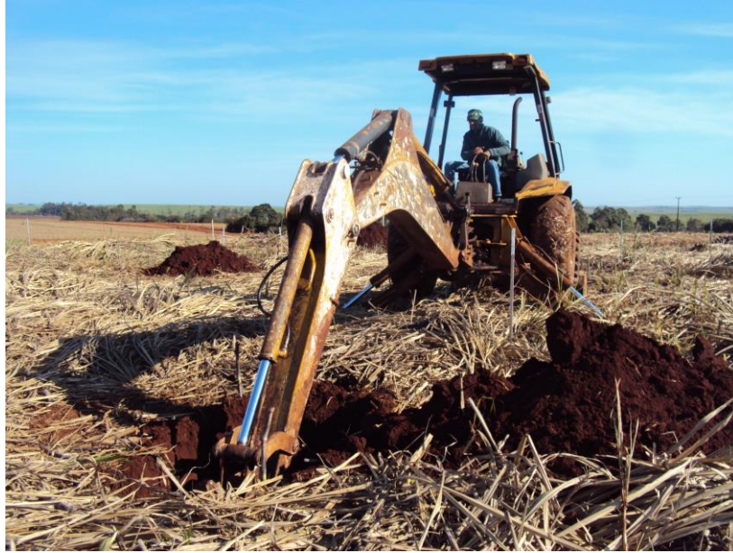
Figura 6: Aspecto geral da máquina abrindo as trincheiras na área experimental. Foto: VIECELI, T. H. A., 2017.
