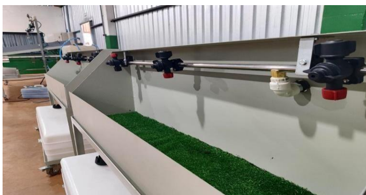
Figura 4 - Calhas coletoras da pulverização
