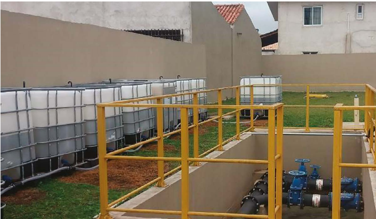
Figura 02: Contêineres de \text{Ca}(\text{NO}_3)_2 na EEE Patrícia.
