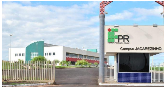
Figura 07- Instituto Federal do Paraná – Campus Jacarezinho
